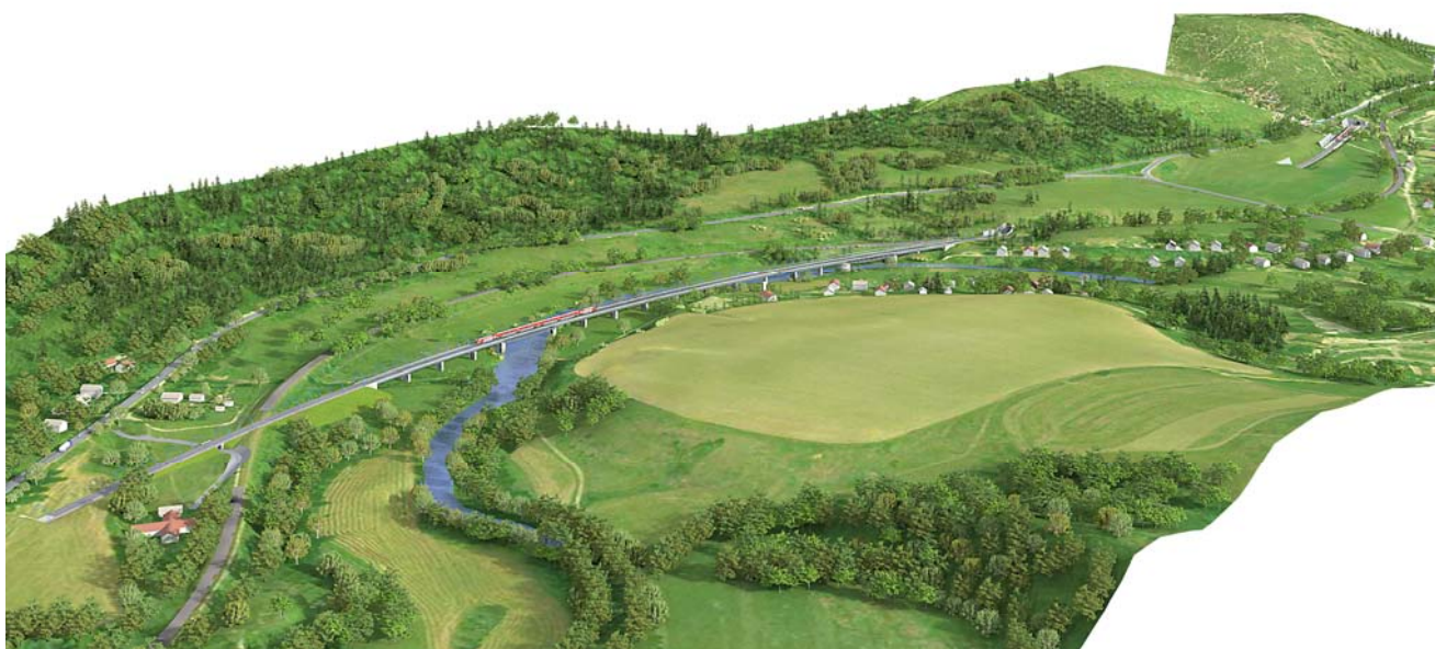
preložka trate pri obci Kluknava
