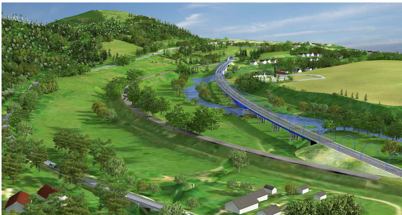
preložka trate pri obci Kluknava
