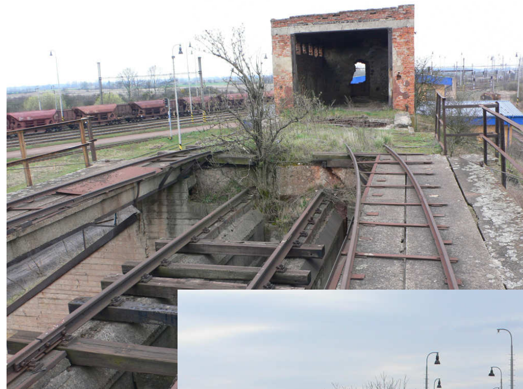
Objekt pôvodnej garáže pre vozíky na konci III. Vysokej rampy
