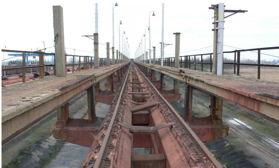
Mostný objekt III. Vysokej rampy
