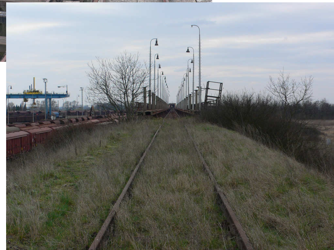
Prístup na III. Vysokú rampu po koľaji širokého rozchodu 938š
