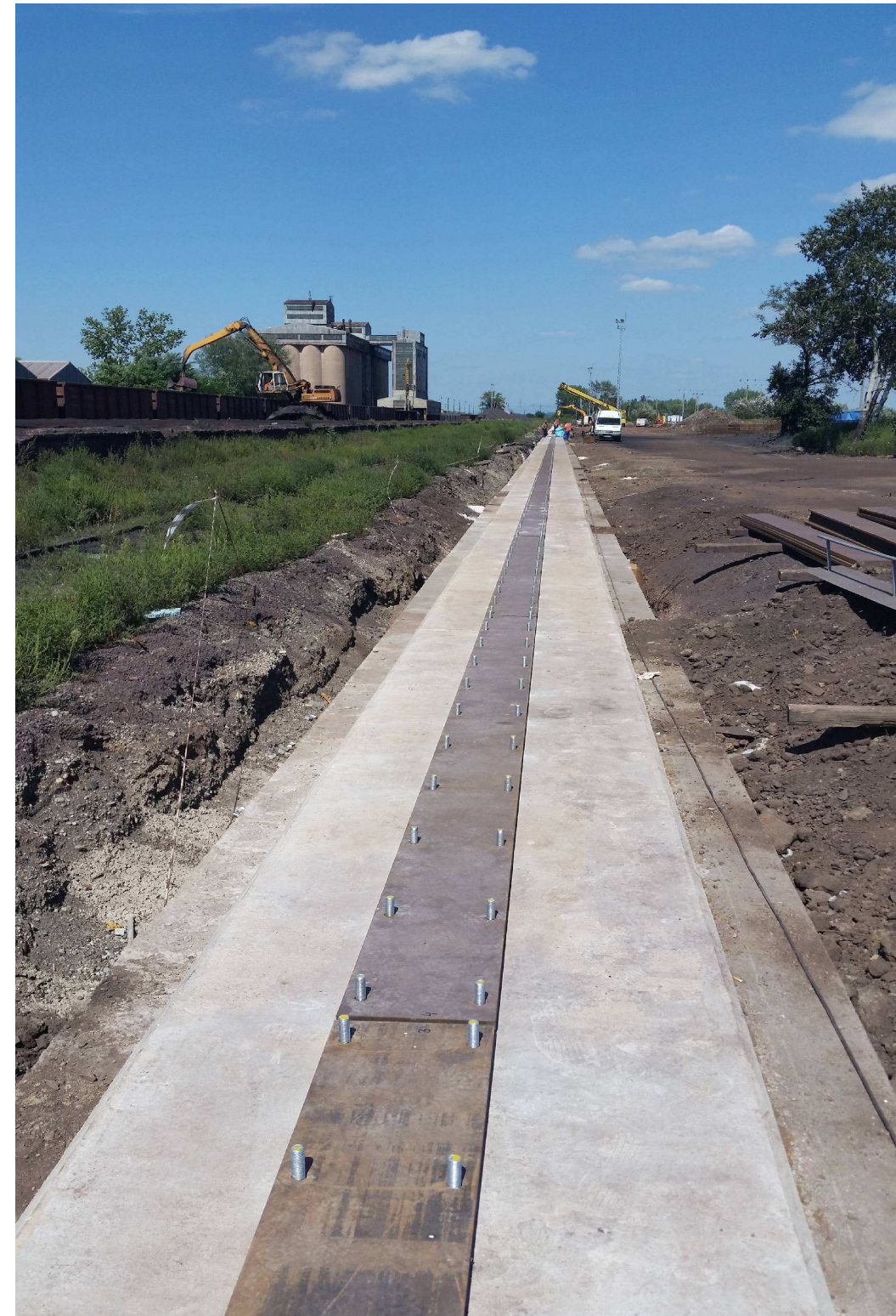
REALIZÁCIA ŽERIAVOVEJ DRÁHY
