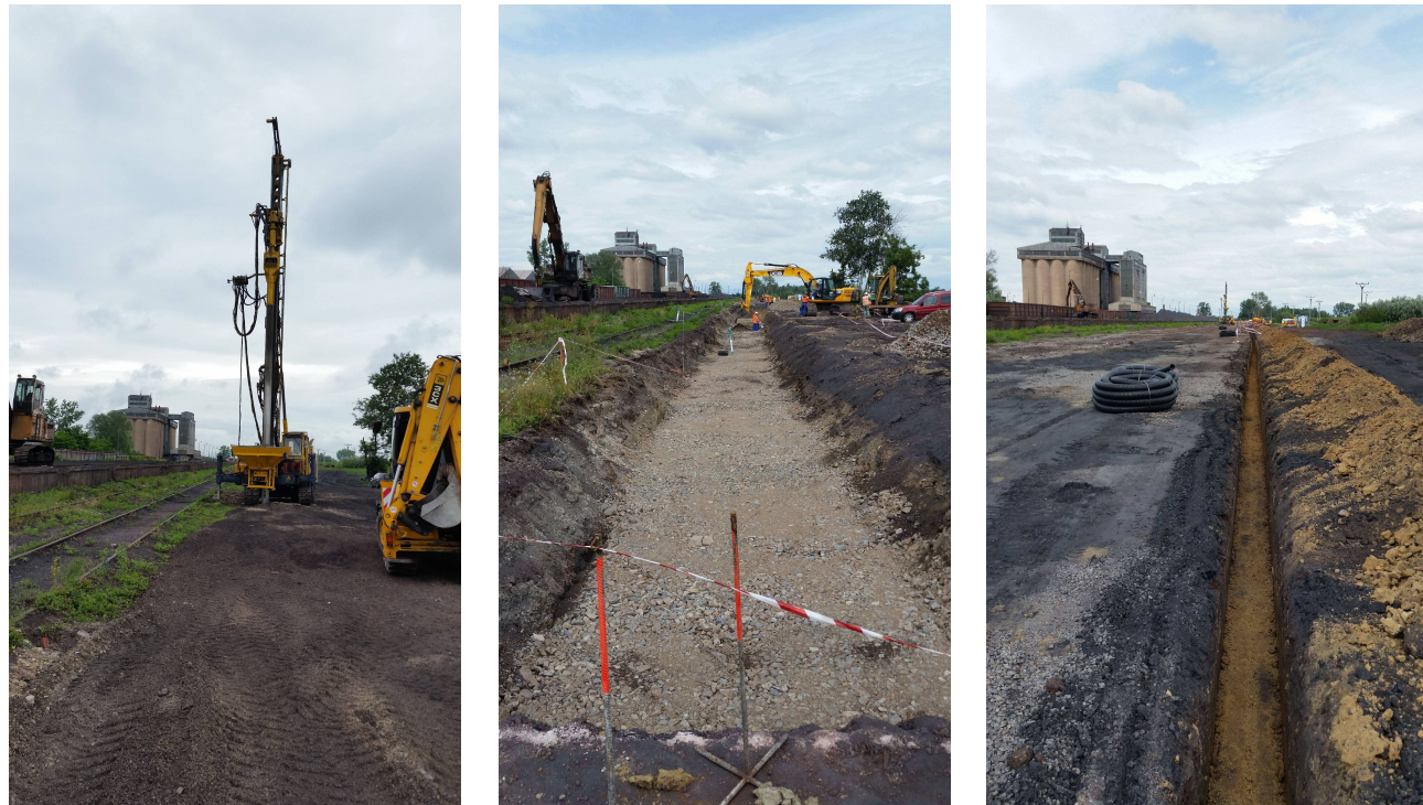
REALIZÁCIA ZAKLADANIA ŽERIAVOVEJ DRÁHY A NN ROZDVODOV VO
